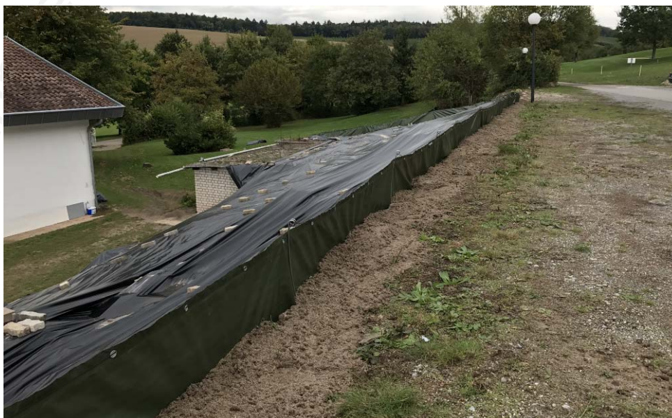
Abb.5: Fertig aufgestellter Zaun mit Anböschung von Sand zur Verhinderung der Untergrabung
