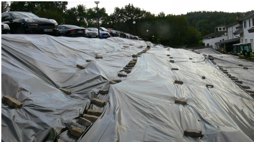
Abb.4: Mit Folie vollständig abgedeckte Böschungfläche
