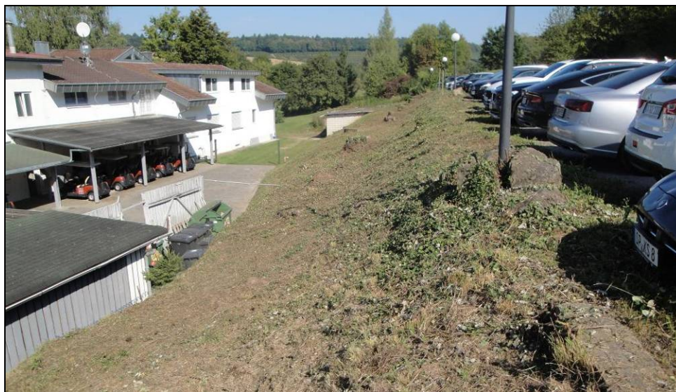
Abb.2: Gemähte Böschung westlich des Parkplatzes
