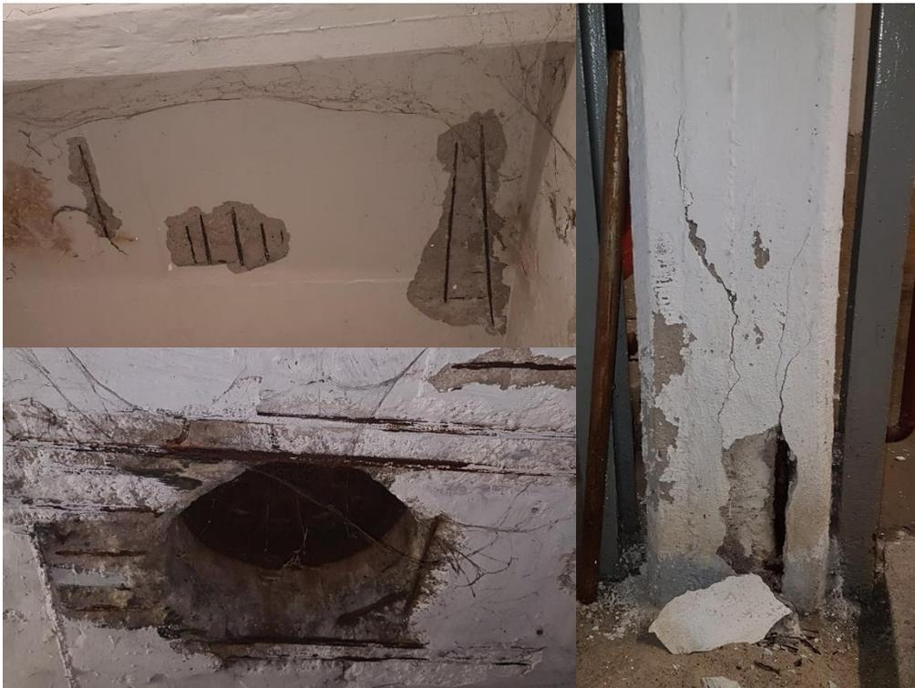
Bild 2 – Geschädigte Kellerdecke und Deckenstütze
