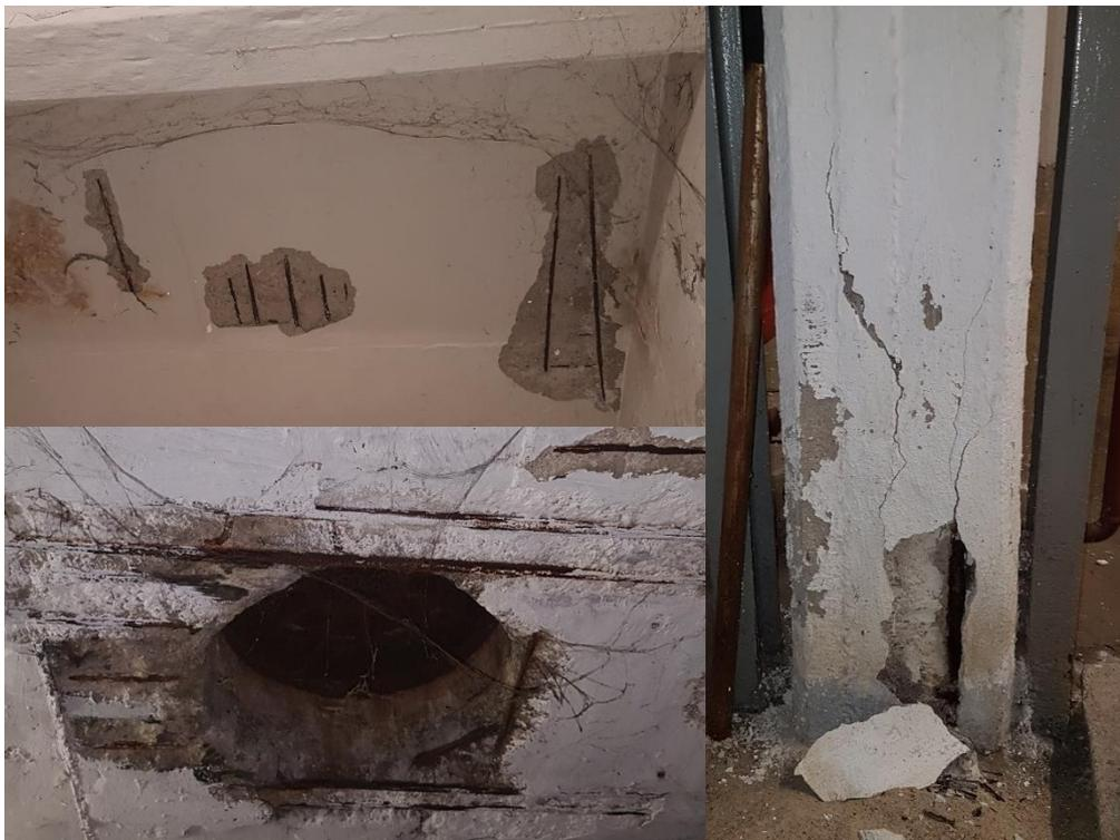
Bild 2 – Geschädigte Kellerdecke und Deckenstütze
